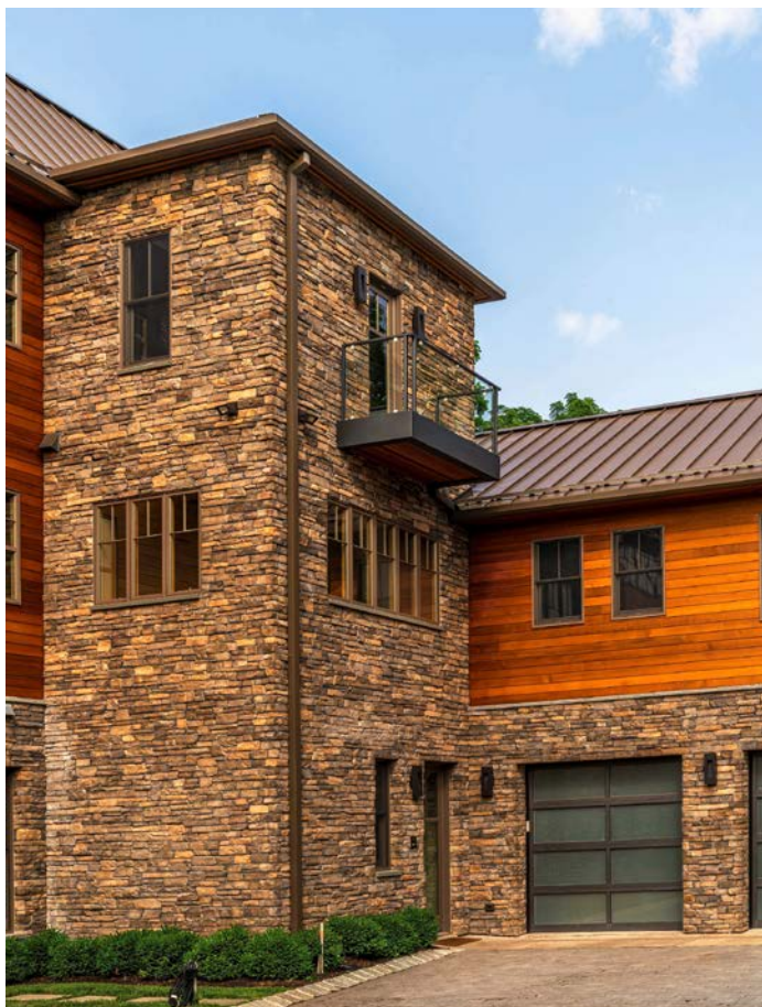
Der Treppenturm fungiert als Scharnier zwischen den Gebäudeflügeln. Der von Ruf & Keller erstellte Balkon dient im Brandfall zum Anleitern.
