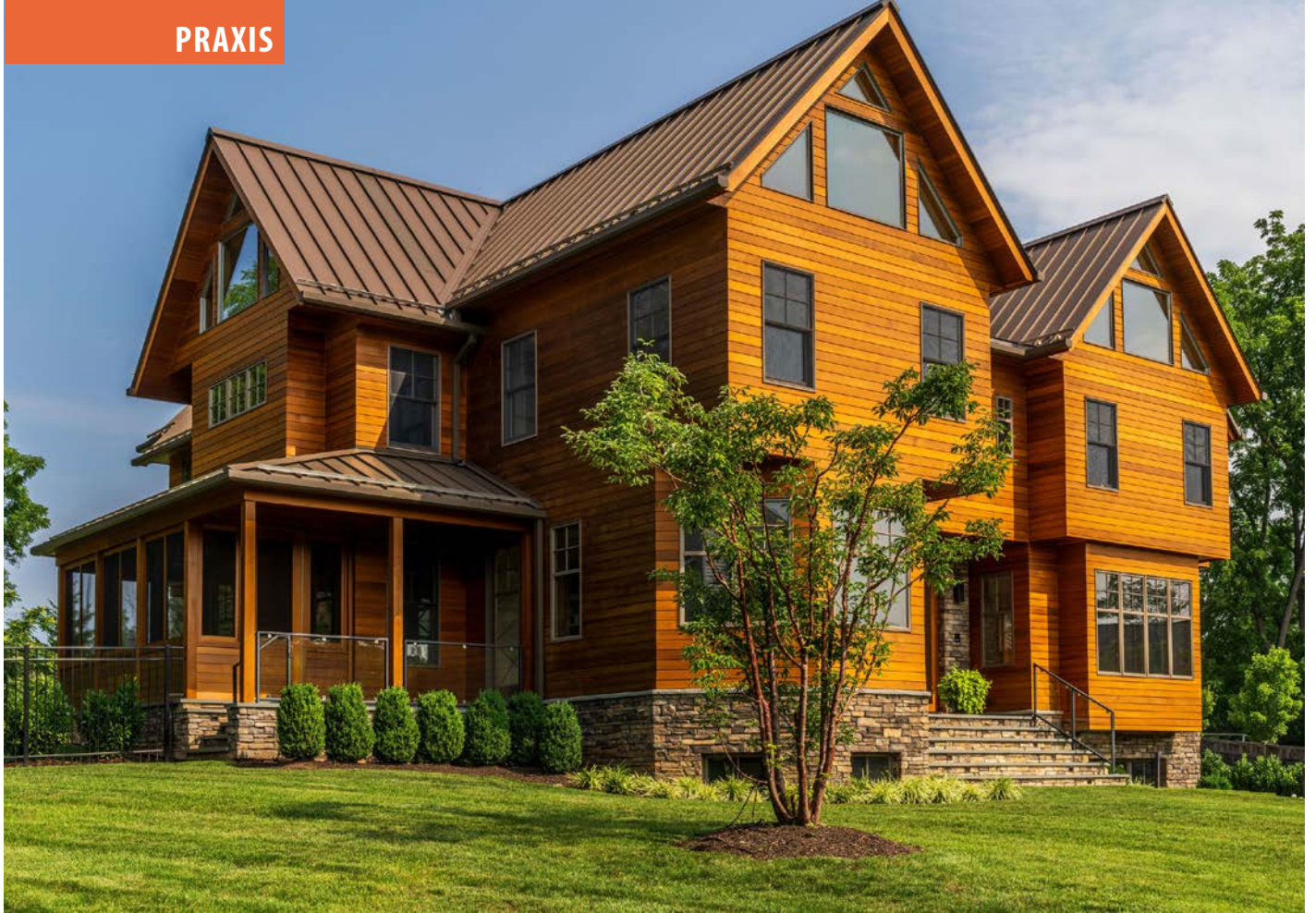
Südensicht des Gebäudes mit dem geschützten Freisitz, dem Screen-Porch, auf deutsch «Fliegengitterveranda».
